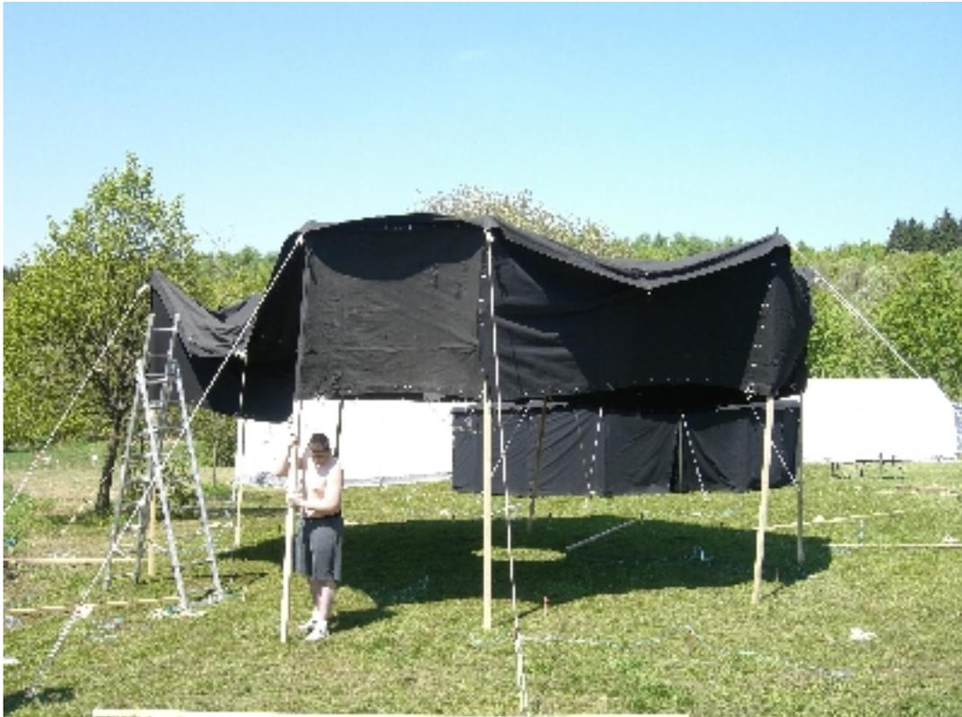
Zwischendurch müssen wir Gestehen, ist uns das ganze einmal umgekippt da wir einfach die Kraft des Windes unterschätzt haben. Als aber die 4 Stangen standen, war das Gewicht schon recht gut verteilt. Jetzt haben wir nach und nach die weiteren Stangen der Reihe nach aufgestellt und abgespannt.
