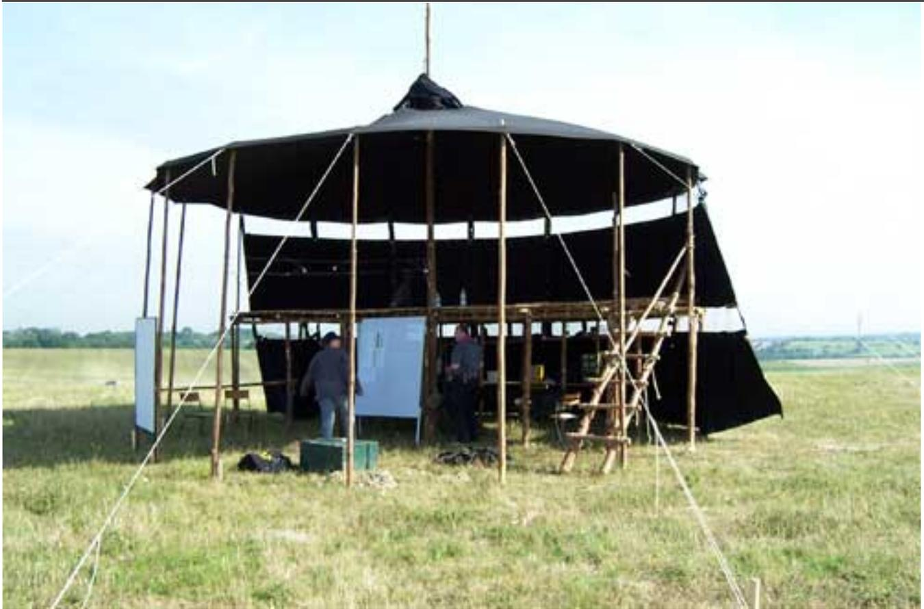
Hier siehst du die Konstruktion im Inneren der Jurte, welche komplett aus Stangenholz und Schwartenbrettern realisiert wurde, um trotz der vielen Technik ein pfadfinderisches Bild zu bieten. Lediglich bei den Pinnwänden sind wir Kompromisse eingegangen, da diese sehr flexibel gehandhabt werden sollten.
