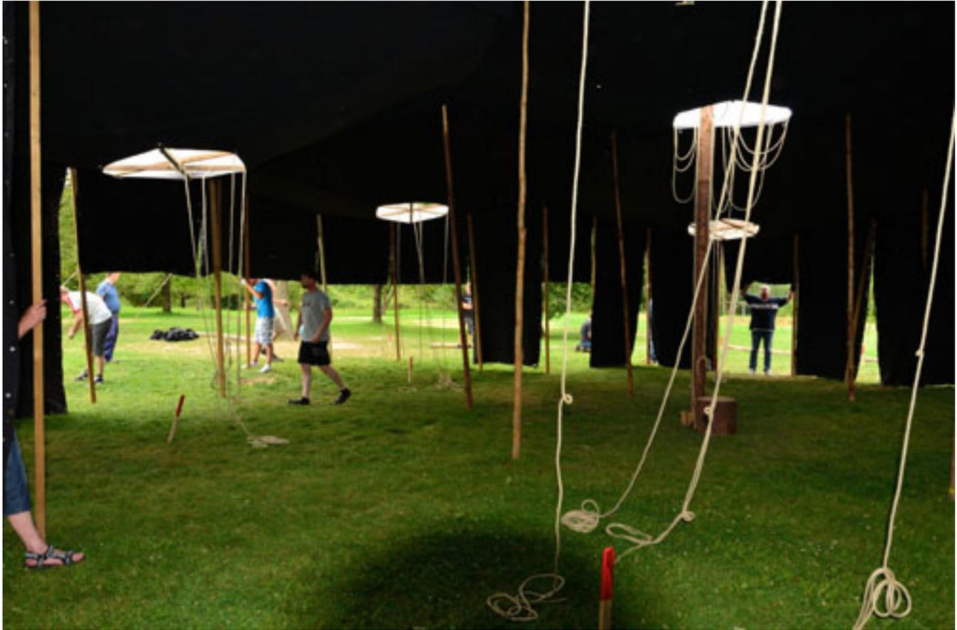
Von innen sieht die Jurtenkonstruktion inzwischen so aus. Später werden hier nur noch sieben Stützen stehen. In jedem Rauchloch eine. Diese tragen das komplette Dach und an den Verseilungen dazwischen können alle anderen Aufhängepunkte abgespannt werden. Gut, wer hier den Überblick bewahren kann.
